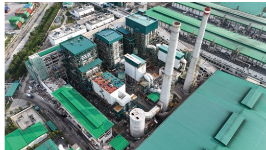
Solid Waste Incinerator of Malaysia Lee & Man 馬來西亞理文固廢焚燒爐
